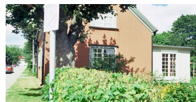
Exempel från Enskede på tillbyggnad av huset på gårdssidan.
