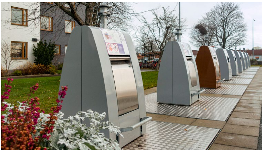
Underjordiska sopkärl installeras löpande. BILD: VICTOR HILDING
