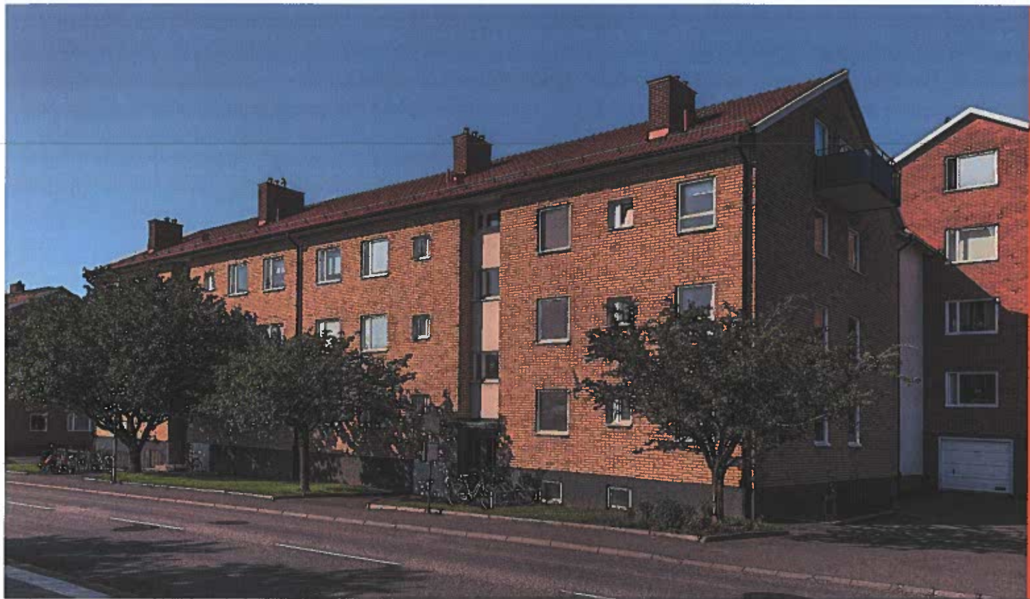
Billingsluttningen – under 2022 startades arbetet med relining av avloppsrör. BILD: VICTOR HILDING
