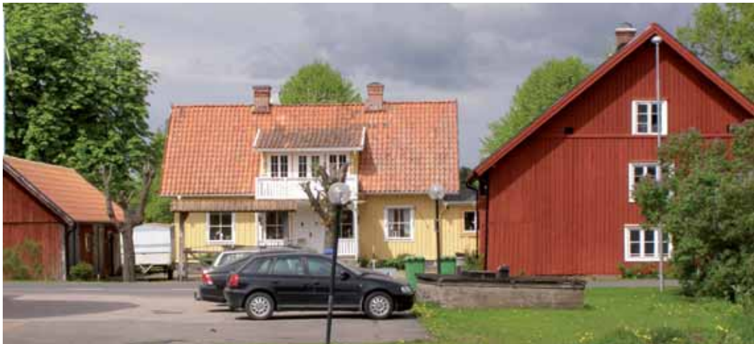
Berglunda 3:6 Den f.d. garvaregården är en väl sammanhållen helhetsmiljö, den ålderdomliga garveribygggnaden är av mycket stort kulturhistoriskt värde.
