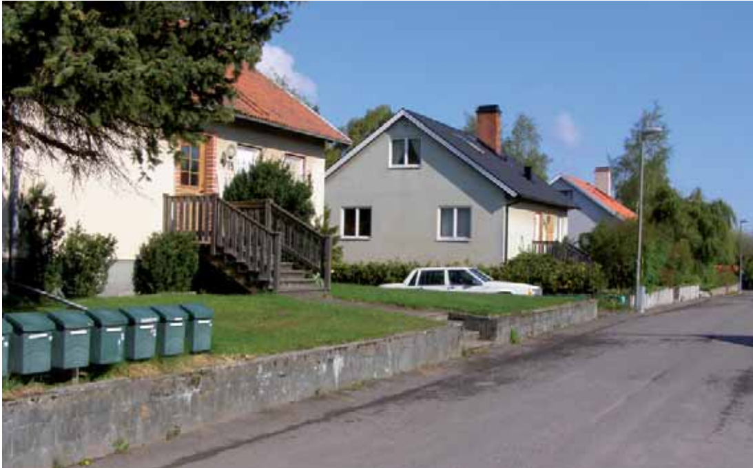
Längs Villagatans västra sida vänder de putsade husen ena långsidan mot gatan.
