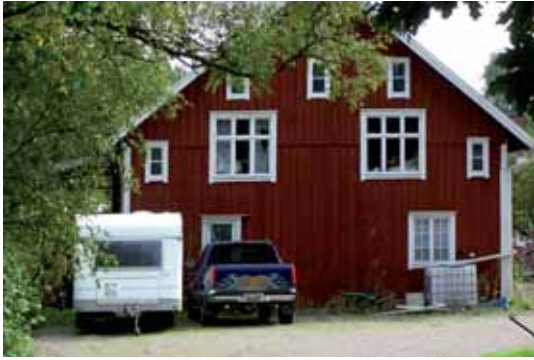
Stora Väring 8:62. Det f.d. bryggerinederlaget är exteriört välbevarat och av stort kulturhistoriskt intresse som en tidstypisk byggnad som ofta fanns på mindre orter.
