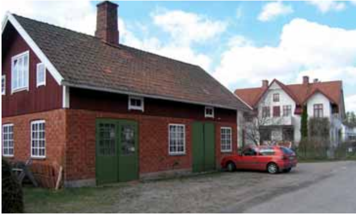
Vid sidan av det f.d. stationshuset utgörs tätortens kärnmiljö ur kulturhistorisk synpunkt av en liten husgrupp från det gamla stations-samhällets tid kring Torsborgsvägen. Här finns bl.a. Villa Viola och den mycket välbevarade smedjan från 1926, Ulvängen 1:13 .
