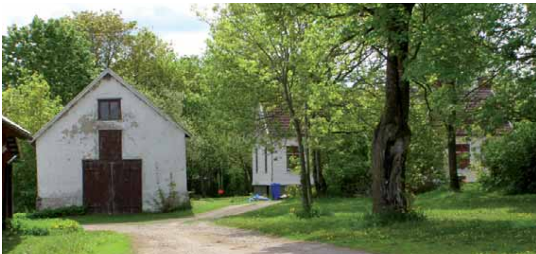
Värsås 5:4 och 2:2 Skattegården Välbevarad gårdsmiljö bl.a. med mangård med manbyggnad troligen från sent 1800-tal med fasad i vitmålad liggande spontad panel och två mangårdsflyglar, dels en faluröd, dels en långa delvis i gutteknik med spröjsade fönster och stora slagportar.
