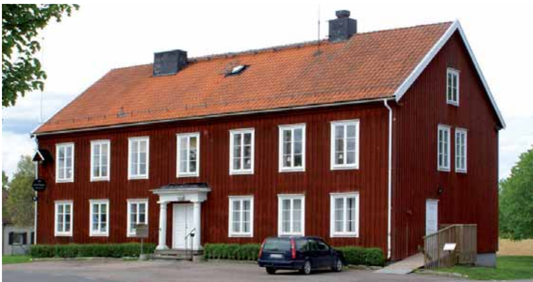
Värsås 8:52 Värsås tingshus f.d. Vid Tingshusbacken nära kyrkan står tingshuset från 1811-1813 som är ett av Skövdebygdens mest förnämliga minnesmärken över äldre tiders rättskipning och administration.
