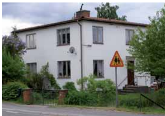
Timmersdala 26:6 Nyhem byggt i funkisstil 1944 är väl bevarat. Detta är en mycket bra representant för de många bostadshus som byggdes i samhället på 1930- och 40-talen.
