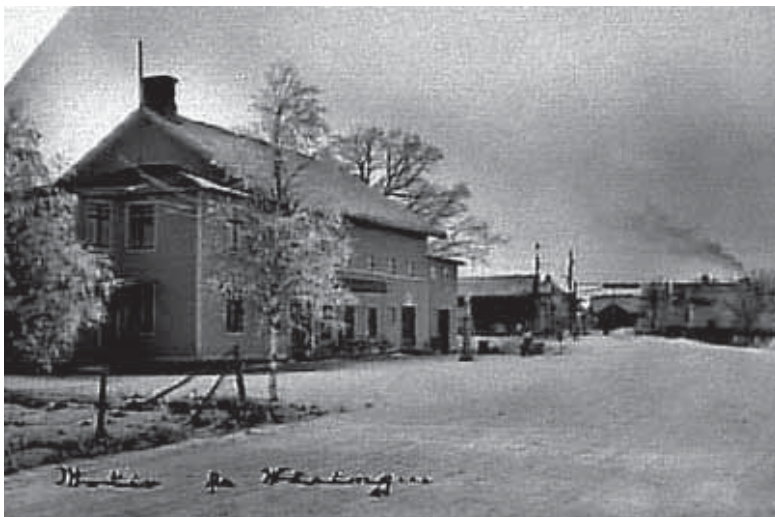
Dahlin's järnhandel delade först byggnad med bankkontoret fram till att huset brann ca 1920. Från 1921 till nedläggningen 1988 inrymdes järnhandeln i ett f.d. spannmålsmagasin som byggts om till bostads- och affärslokaler. Dahlin's järnhandel var en karaktärsbyggnad blnad stationssamhällets äldre bebyggelse. Byggnaden revs på 1990-talet i samband med att vägkorsningen med järnvägen byggdes om och viadukten tillkom. Bild troligen från ca 1930. Foto: Anders Karlsson. VGM.
