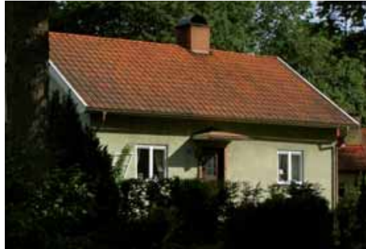
Stora Väring 10:52 Detta är ett äldre timmerhus som byggdes om helt på 1950-talet och har en välbevarad 1950-talsexteriör frånsett en yngre ytterdörr. Huset har bl.a. en mycket tidstypisk 1950-talsfasad i grön ädelputs, entré med smide och tegelomfattning, karaktäristiska fönster och tvåkupigt taktegel.
