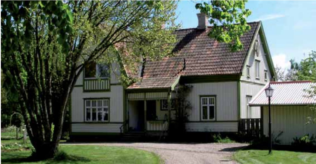
Värsås 2:9 Åkershäll med den välbevarade villan från 1917 och dess starka koppling till Värsås som byggmästarsocken är av stort kulturhistoriskt intresse.
