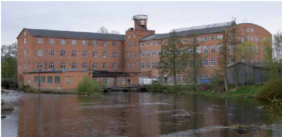
Vads-Kvarntorp 2:1 F.d. Westergötlands Yllefabrik är en stor och mycket välbevarad textilindustribyggnad från 1910-talet, ett av de mest förnämliga industriminnena i Skövde kommun.
