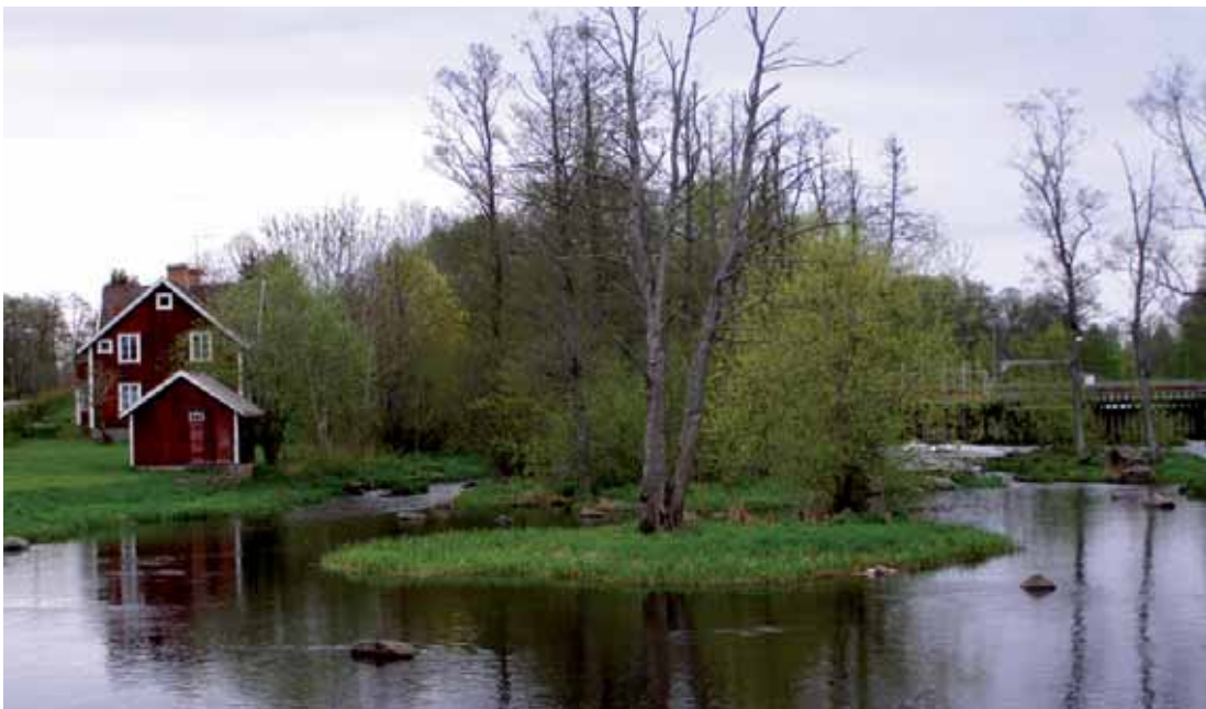
Vy mot Vad 5:38 Kvarnegården/Sörgården från 1916 och dammanläggningarna vid den f.d. Yllefabriken.
