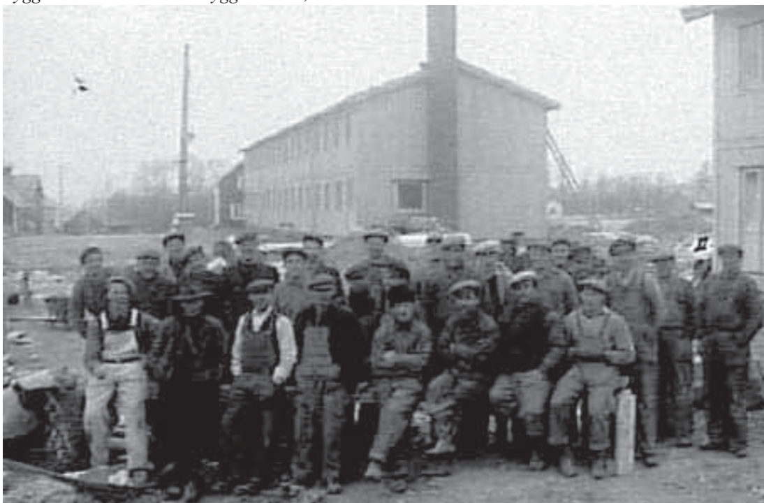
Byggnadsarbetare vid husbygge i Tidans, ca 1945-1950. Foto: Anders Karlsson. VGM.
