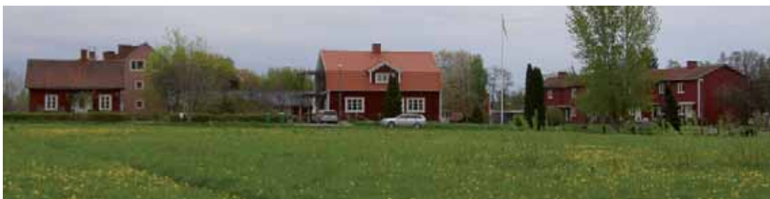
Vad 17:1 Spinnarevägen norr om ån präglas till stor del av bostadsbebyggelse som förknippas med textilindustrin. Till vänster syns Vad 5:37 Anneberg från ca 1930, Vad 5:36 från ca 1915-1930 och till höger radhusen från sent 1940-tal vid Sörgårdsvägen, Vad 5:39-5:60 .
