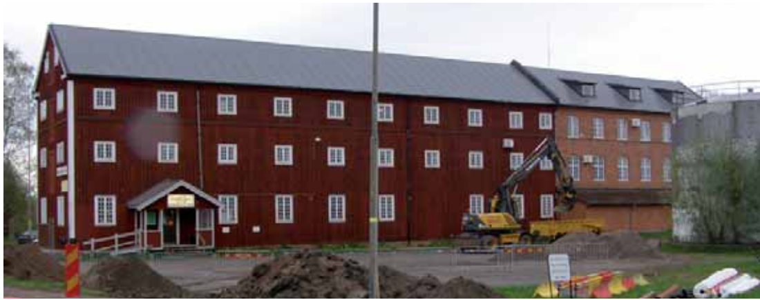
Vads-Kvarntorp 2:1 F.d. Westergötlands Yllefabrik. Från 1911 härrör flera byggnader, bl.a. de från söder mest dominerande byggnaderna, ett plyschtillverkningshus i tegel i tre våningar, sammanbyggt med en faluröd större lagerbyggnad i panelat trä, båda är mycket välbevarade.
