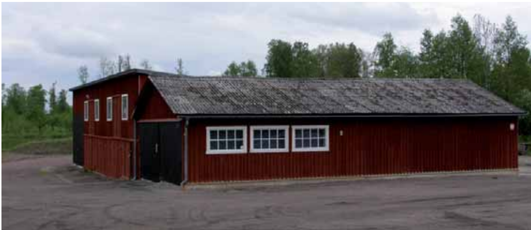
Lunne 6:8 Lunne såg. Sågverksbyggnaden blev ombyggd eller nybyggd på 1940-talet, exteriören är mycket väl bevarad sedan dess.
