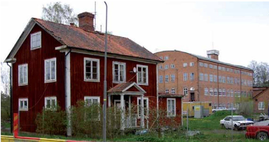
Vads-Kvarntorp 2:1 F.d. Westergötlands Yllefabrik. Från 1911 härrör flera byggnader, bl.a. det stora spinneriet/väveriet i tegel som är en kärna i bebyggelsemiljön samt i förgrunden ingenjörsvillan som också är en mycket viktig byggnad i fölrståelsen och upplevelsen av industrimiljöns helhet och stora kulturvärden.
