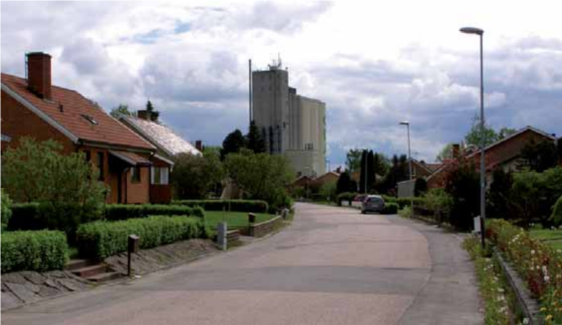
Närlundavägen översikt mot gatans södra del.
