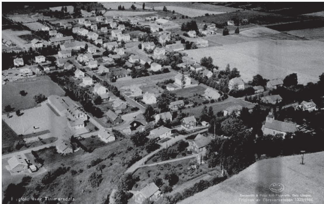
Flygfoto från 1950-talet över Timmersdala tätort. Kyrkan syns till höger nere i bild. Till vänster syns Timmersdala skola som byggdes 1951-1952. Ålderdomshemmet och kommunhuset har ännu inte uppförts (tillkommer 1964-1965) vilket daterar bilden till mellan 1952 och 1964. Foto: AB Flygtrafik, Dals-Långed. VGM.
