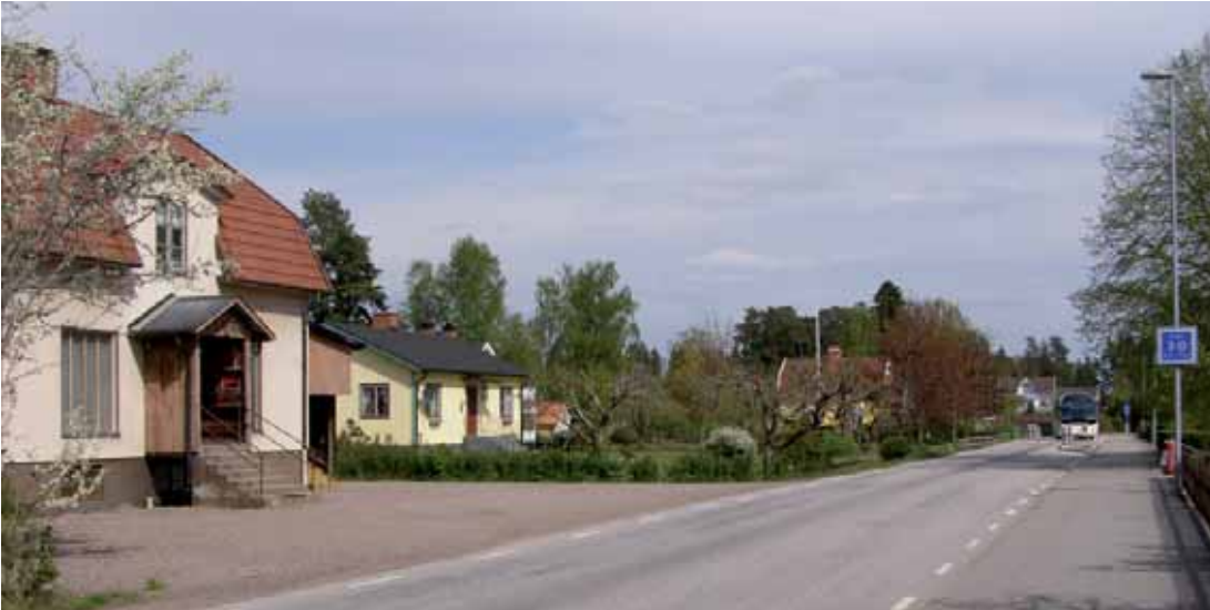
Stora vägen mot öster vid den f.d. affären Altorp 1:24 Grantuna.
