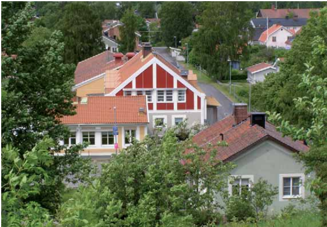
Timmersdala skola byggdes 1951-1952 och äldreboendet Billingsdal byggdes 1964-1965, jämte kommunalhus och bibliotek. Sammantaget finns här en mycket intressant bebyggelsemiljö med institutionsarkitektur i 1950-talmodernism, en av de främsta i Skaraborg i sitt slag.
