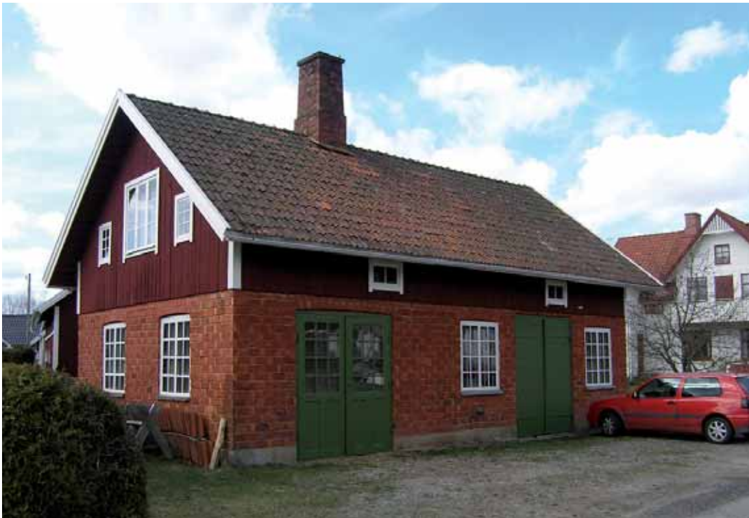
Ulvängen 1:13 Villa Viola Smedjan från 1926 är kulturhistoriskt värdefull och är, i likhet med Villa Viola från samma tid, av största lokalhistoriska betydelse med sin starka förankring i stationssamhällets framväxt på 1920-talet.
