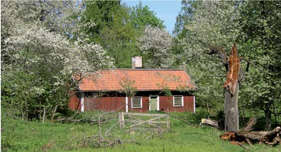
Ryd 15:43 På Lilla Åsen finns endast det timrade lilla bostadshuset kvar, idag bör det vara ett av de äldsta i Skövde, det kan mycket väl härstamma från 1700-talet, senare tillbyggt med en karaktäristisk enkel bod i resvirke vid ena gavelsidan. Lilla Åsen ligger inom naturreservatet.
