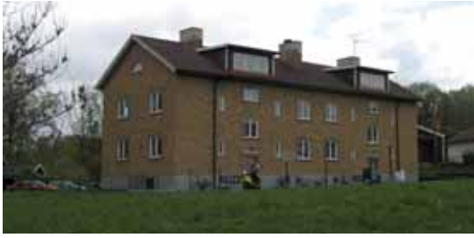
Våmb 30:70. Flerbostadshus från ca 1950 med koppling till Gullhögens bruk.
