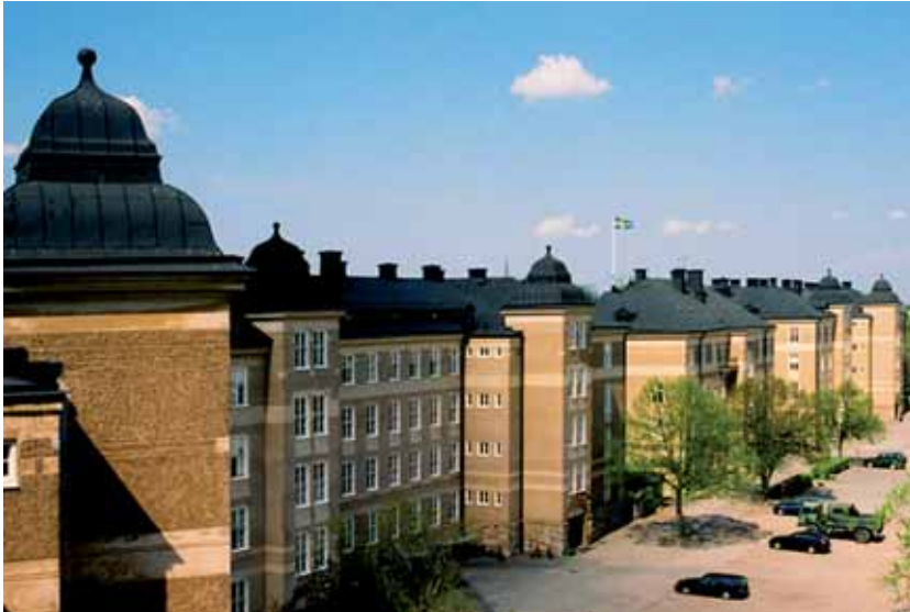
Skövde 5:259 P4:s välbevarade etablisement från 1913 är numera skyddat som statligt byggnadsminne.
