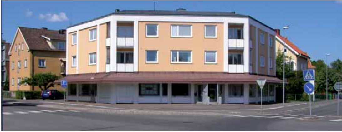
Bläckfisken 14 byggt som bankhus 1958-60 och med mycket av den modernistiska karaktären i behåll även idag.
