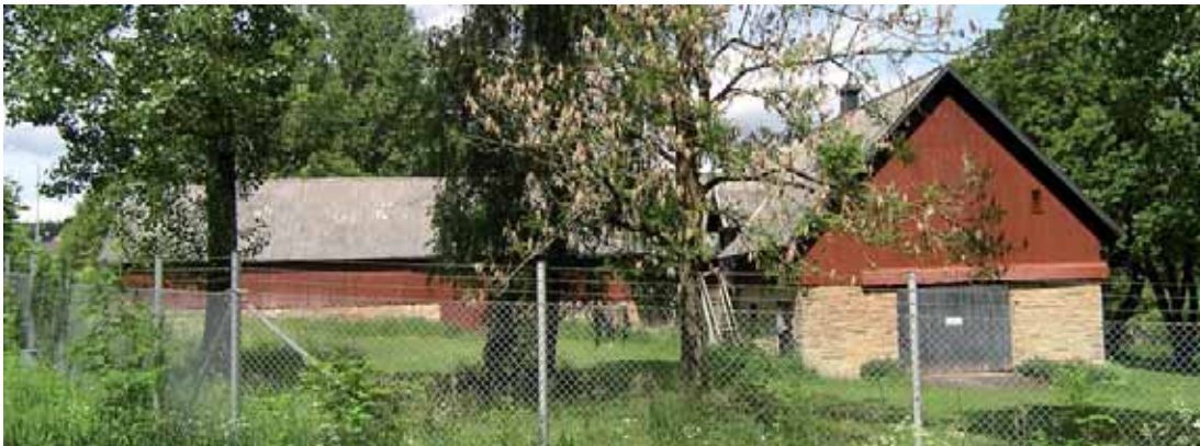
Våmb 30:76 Persberg. Egendomens stora ladugårdslänga uppförd 1917 av kalksten från trakten.
