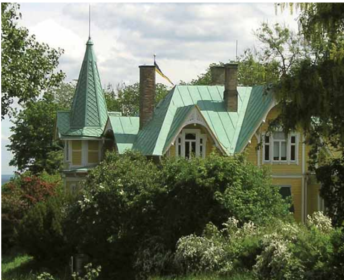
Våmb 30:76 Persberg. Manbyggnadens exteriör i riklig panelarkitektur är i mångt och mycket bibehållen sedan 1880-talet, något moderniserad på 1930-talet.
