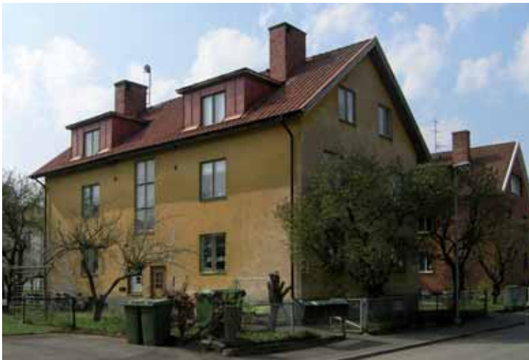
Havren 6. Mindre hyreshus byggt 1945 med en i stort bibehållen utformning.
