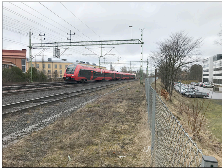
Västra stambanan mellan högskolan och Science Park Skövde på var sin sida.
