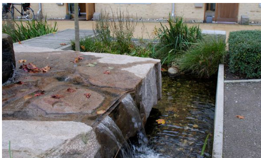
Exempel på öppna dagvattenlösningar som även fungerar som visuellt tilltalande element i Mossagårdsparken. (Foto: Veg Tech AB)
