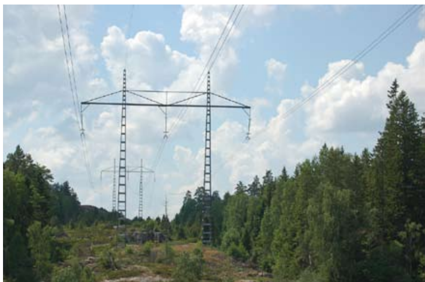
Ledningsgata väster om Sparresäter.
