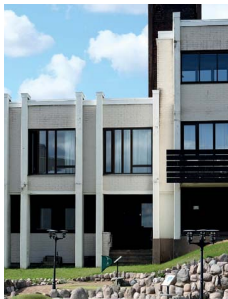
Del av den äldsta hotellbyggnadens fasad mot öster med varierande takhöjder och fönsterutformning. (Äventyrsgolfbanan i förgrunden är från senare tid.)
