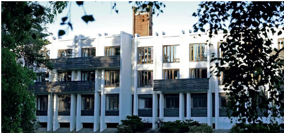
Figur 27. Hotellet med dess tidstypiska fasad. Vitmålad betong och ljus kalksandsten i kombination med brunlaserat trä (Foto: Skövde kommun).
