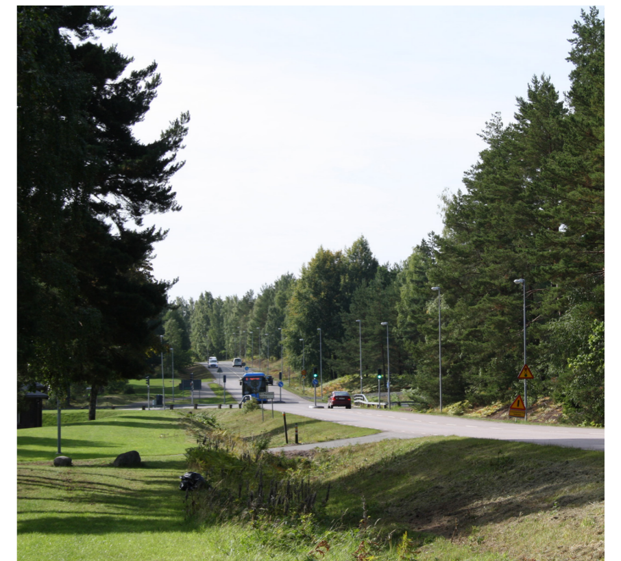
Bild 18. Västra Skogsrovägens korsning med Timmervägen.
