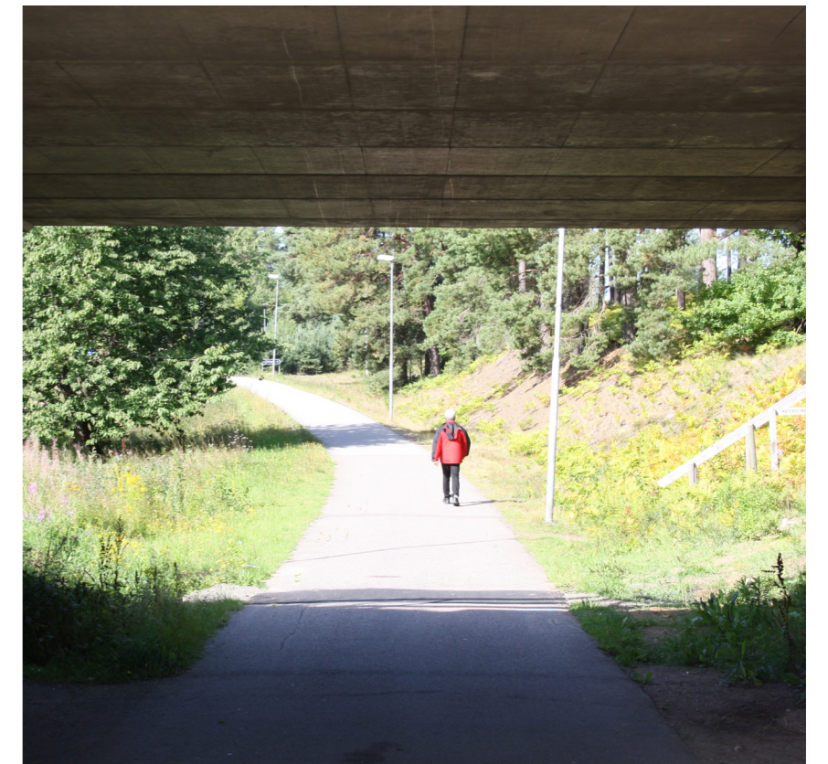
Bild 17. Befintlig gångtunneln under Västra Skogsrovägen mot Västra Ryd.
