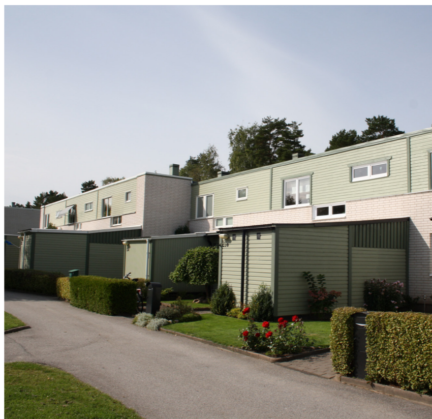
Bild 25. Radhus vid Fredriksbergsvägen.
