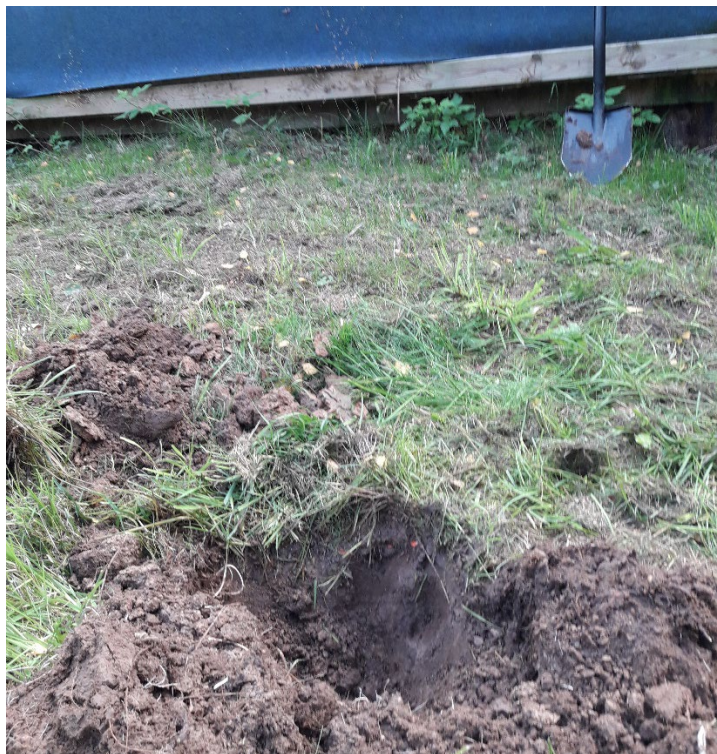
Figur 14. Grävning av ytlig provgrop, område A.
