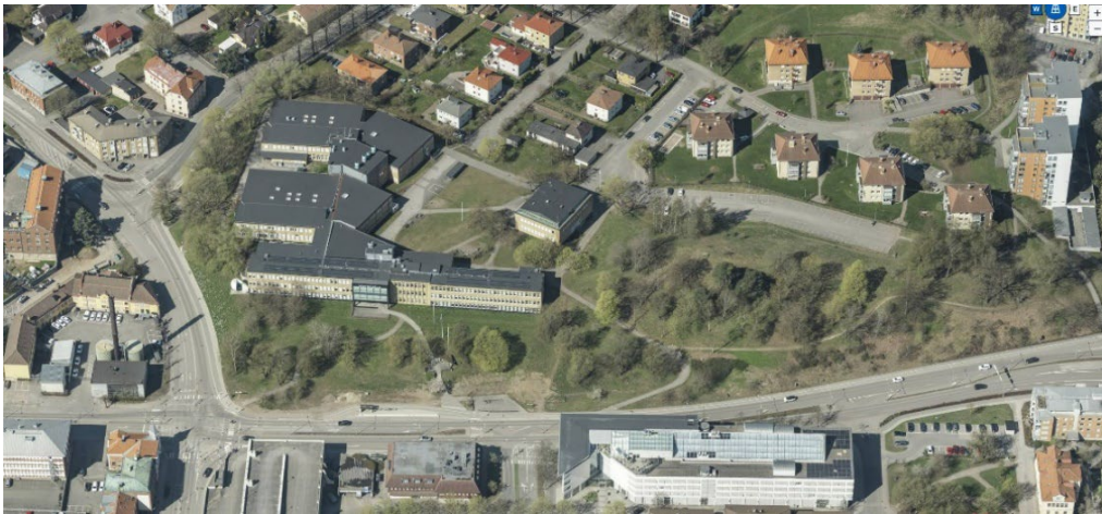
Ortofoto på Västerhöjdsgymnasiet sett mot väster.
