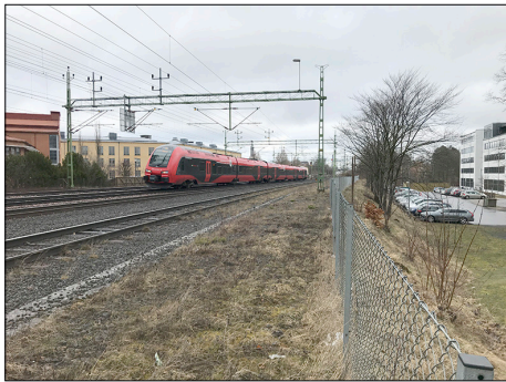
Västra stambanan mellan högskolan och Science Park Skövde på var sin sida.
