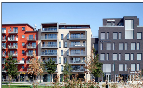
Exempel på varierande fasader. Kv Klyvaren, Malmö (Link Arkitekter)
