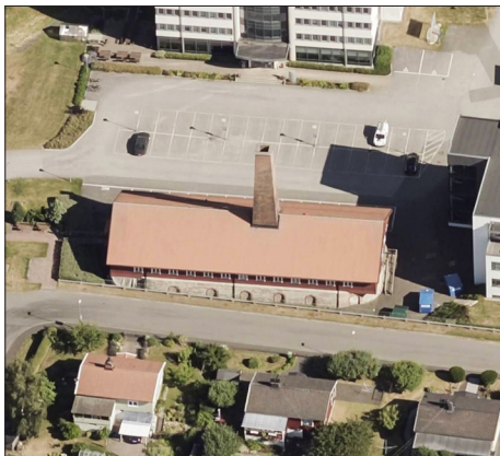
F.d tegelugnen, numera kontorsbyggnad på fastigheten Tegelbruket 5
