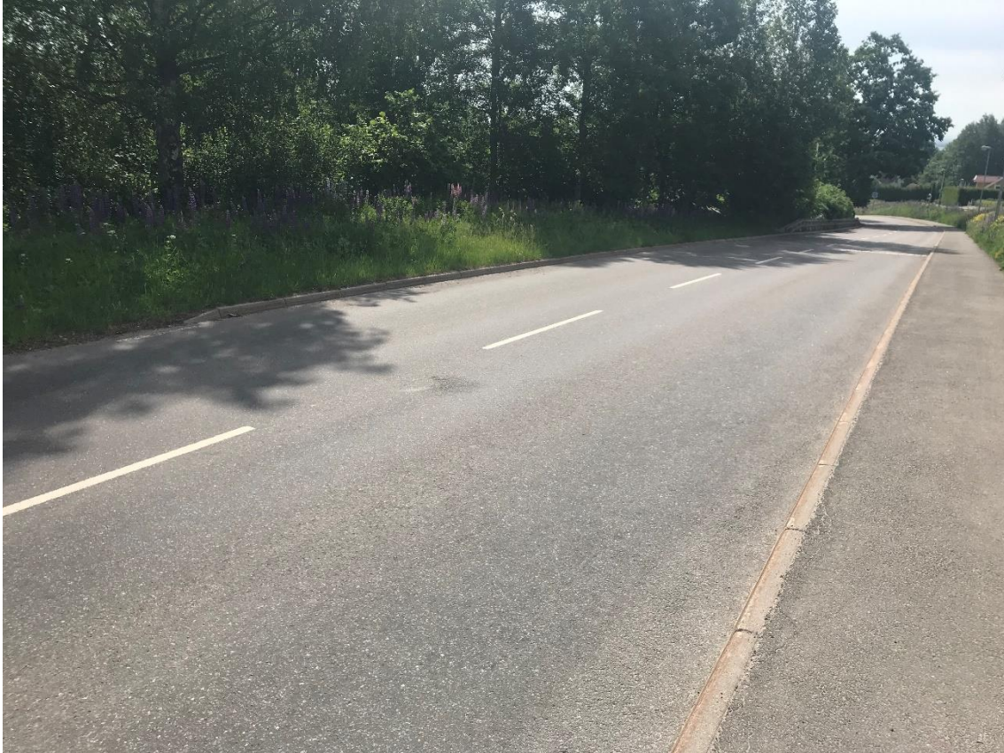
Figur 12. Bild 6. Vy söderut längs Lerdalavägen. Södra delen av planområdet finns till vänster om vägen. Man kan se kantstenen som löper längs Lerdalavägen i södra planområdet och förbi grannfastigheten (i söder) som finns bakom träden längst upp i bilden.
