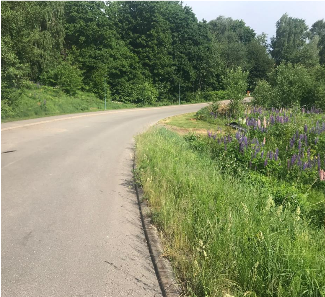
Figur 10. Bild 4. Vy österut längs Källtorpsvägen. Till vänster (norr om vägen) finns sänkan med brunnen och till höger (söder) om vägen utloppsledningen.
