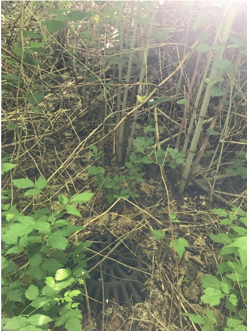
Figur 7. Bild 1. Visar identifierad brunn i sänkan söder om planområdet och norr om Källtorpsvägen. Bilden är tagen mot vällen upp till Källtorpsvägen.
