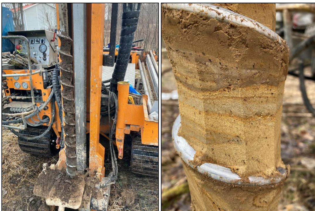
Figur 4. Första bilden visar skruven vid provtagningspunkt 22RE02 (mörkare fyllnadsmaterial) och andra bilden visar blandade lagar vid provpunkt 22RE08 på en djup mellan 1 och 2 meter.
