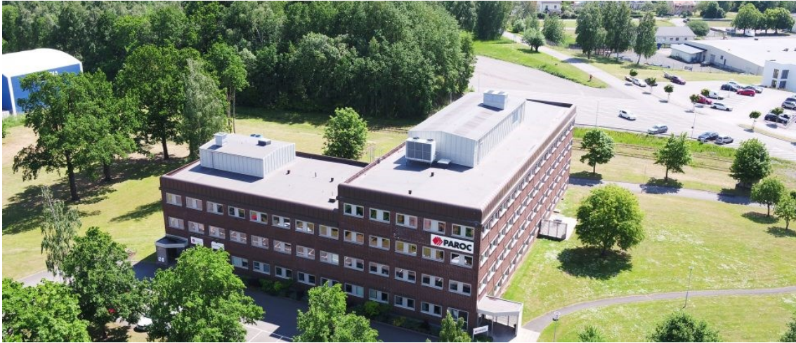
Bild över befintlig byggnad.
