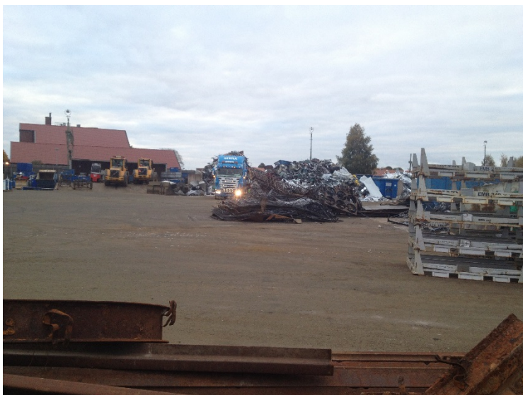
Bild 1. Del av anläggningen mot öster. Närmast kameran upplag av material som ska fragmenteras med saxen.
