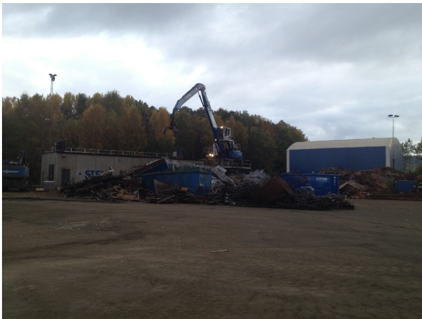
Bild 3. Sax och kran. Saxen är placerad i den grå byggnaden. Kranen i arbete.
