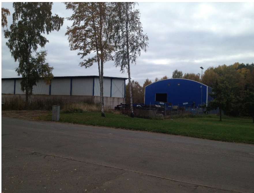
Bild 8. Bruksgatan 5. Vy från mätplatsen mot anläggningen.
