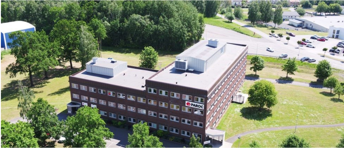
Bild över befintlig byggnad.
