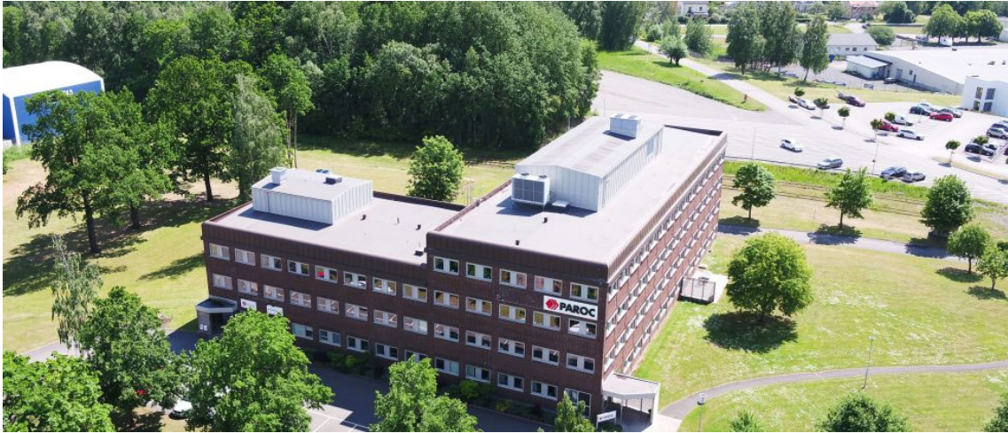
Bild över befintlig byggnad.
