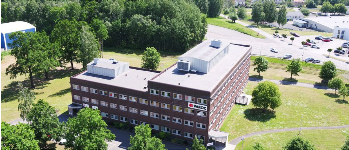
Bild över befintlig byggnad.
