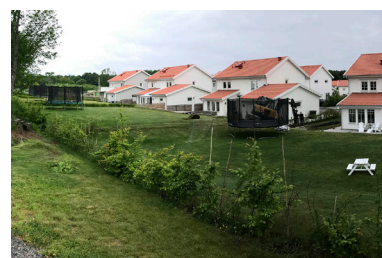
Ovan två bra exempel från etapp 2 på hur man kan ta upp tomtens nivåskillnader i mötet med omgivningen.
