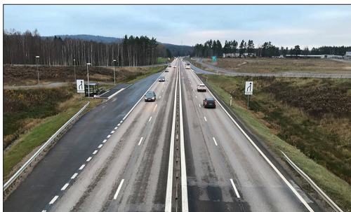
Väg 26 norrut mot Mariestad från den nya trafikplatsen.
