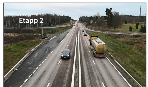
Väg 26 söderut mot Skövde från den nya trafikplatsen. Etapp 2 ligger söder om avkörningsrampen öster om vägen (vänster i bilden).
