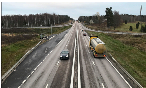
Väg 26 söderut mot Skövde från den nya trafikplatsen.
