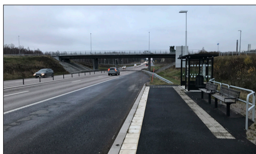
Bussficka och hållplats vid trafikplatsen väster om väg 26 i riktning mot Skövde.
