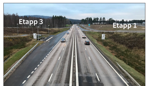
Väg 26 norrut mot Mariestad från den nya trafikplatsen. Etapp 3 ligger norr om avkörningsrampen väster om vägen (vänster i bilden).
