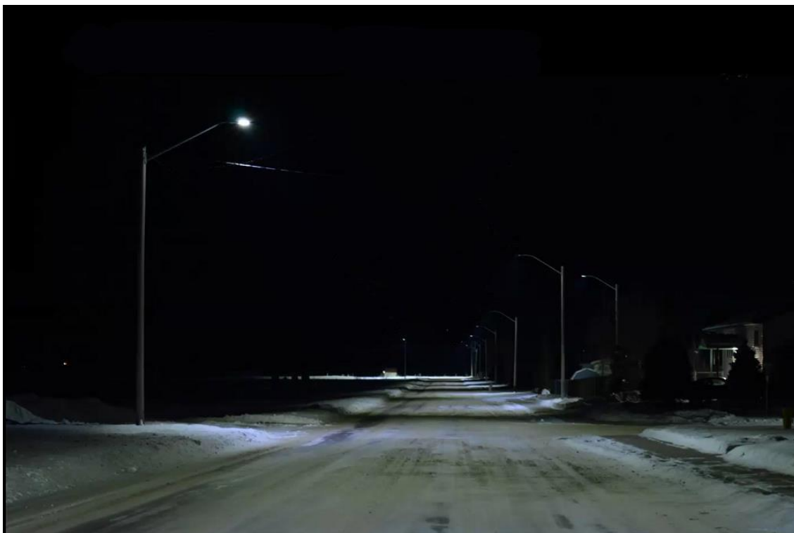
Figur 5. Exempel på gatlampor som har minimal spridning utanför det nödvändiga området. Bild av Chris Kyba från Bat conservation and artificial light – Online workshop, 3 mars 2021
