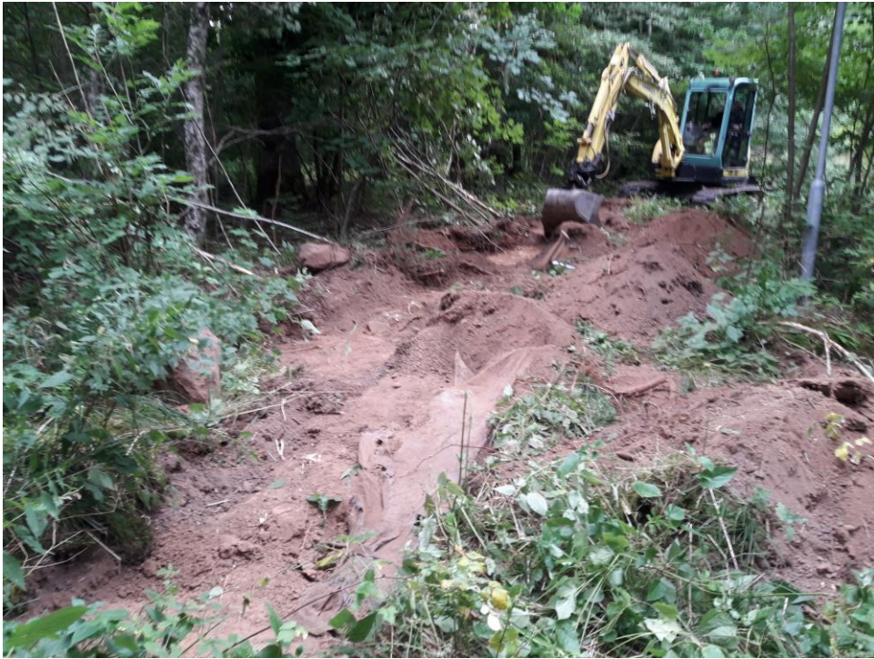
Figur 7. Maskinell grävning gick utmärkt att göra inom de ytor som var något mer öppna (schakt 7), eller så röjdes de från ytvegetation (som t ex nässlor).
