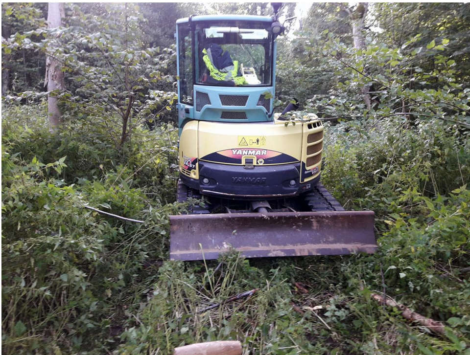
Figur 5. Vid grävning av schakt i den norra delen fick delvis röjas väg in i område där det enbart finns lättare undervegetation in mot det område som tidigare betecknats som betecknats som "fossil åker". Arbetet med att bokstavligt talat tränga sig igenom vegetation innebär att vi såg det som lika bra att återfylla schakter på svårtillgängliga ställen när vi ändå stod på samma plats. På så vis minskade avtrycket av de körskador som annars hade blivit värre med upprepade körningar.
