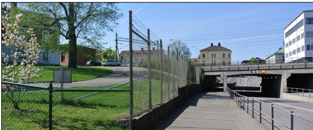
Pentaporten, öster om järnvägen, har en helt annan karaktär med staket som avskärmar.
