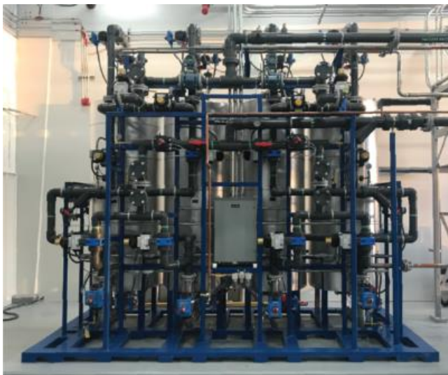
Figur 12. Regenereringssystem på Pease flygbas, New Hampshire USA.
