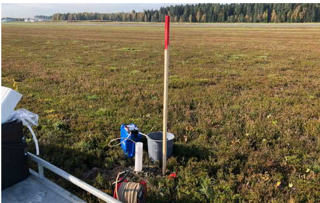
Figur 2. Grundvattenrör i punkt 21TY007. Flygplatsbyggnaderna är synliga i bildens vänstra hörn. Renspumpning 2021-10-08.
